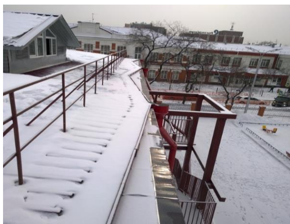
Рис. 3. Система антиобледенения, изготовленная на основе пленочных обогревателей
