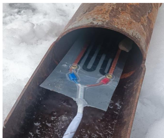
Рис. 4. Испытание пленочного нагревателя в системе водостока дома
