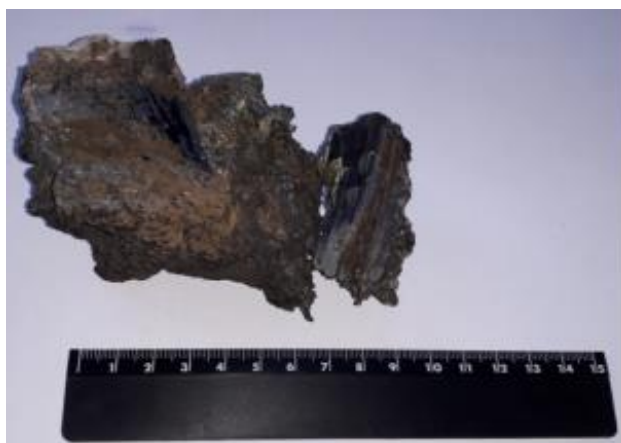
Рис. 6. Металлизация футеровки печи
